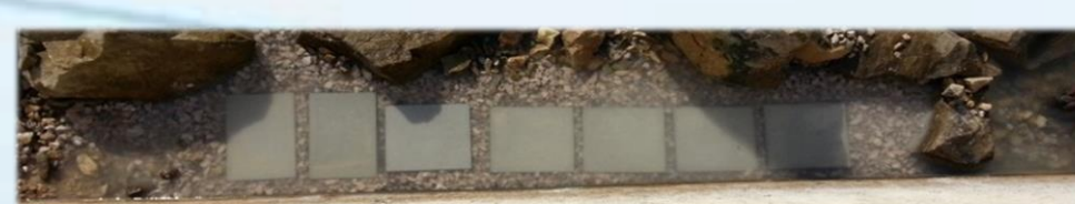
Slika 3. Betonske ploče u moru
